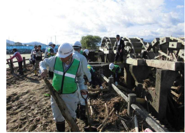
▲ 三連水車除去作業の様子(九州北部豪雨)
