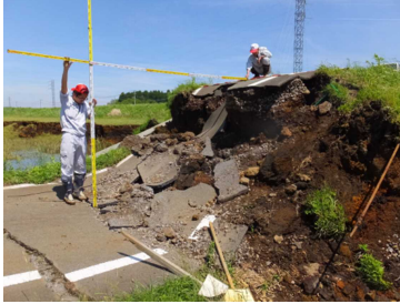
▲ 現地調査の様子(熊本地震)
