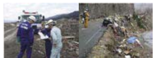
東日本大震災における、緊急災害対策派遣隊（TECFORCE）の派遣
