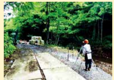
緑に囲まれながらの現場検査
