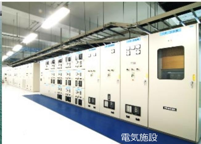
**02** 航空灯火は夜間や悪天候時であっても灯火により滑走路の形状等をパイロットに伝える施設である。また電気施設は空港内で使用される各施設に電源を安定して供給する施設である。これらの施設は空港の運用に欠かせない重要な施設で、航空灯火・電気技術官はその管理・運用・保守並びに整備を行っている。
