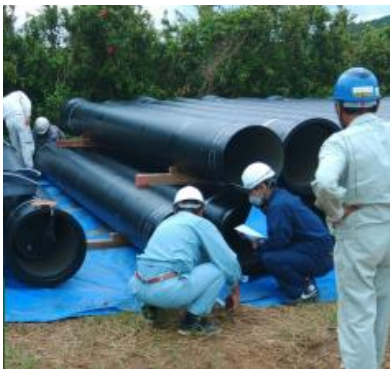
工事現場の立会
