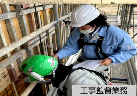
新築工事現場
