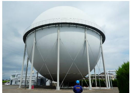
ガス設備の現場確認
