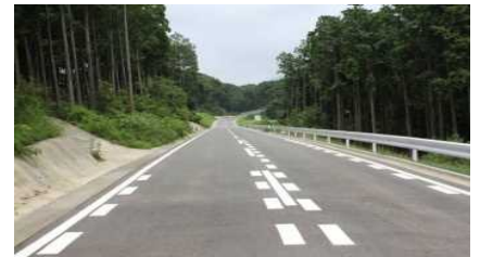
道路改修事業
