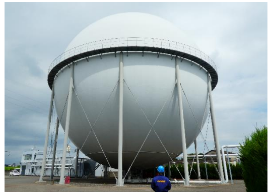
ガス設備の現場確認
