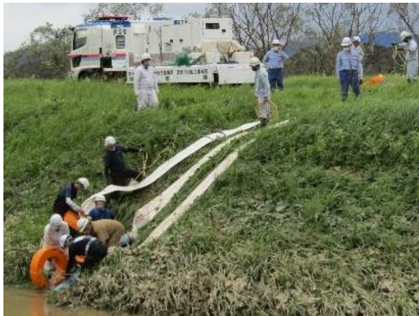
▲ 排水ポンプ車による緊急排水の様子
