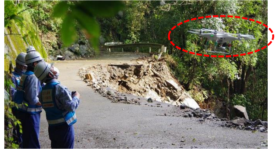
▲ 危険箇所の調査のため、ドローンを活用
