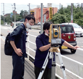
▲土地を測量する様子
