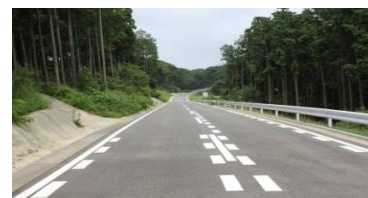
道路改修事業
