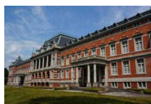
法務省 （旧本館：通称赤レンガ棟）
