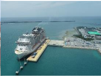
那覇港第二クルーズバースの整備
