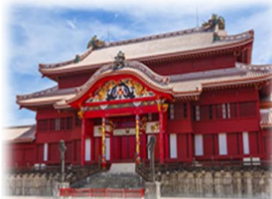
首里城の復元整備
