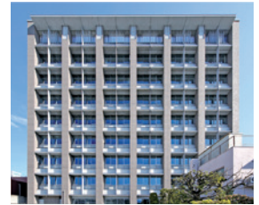
総合庁舎（甲府法務総合庁舎）
