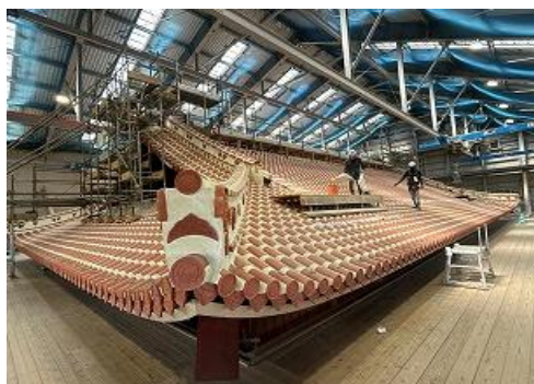
首里城復元工事の様子
