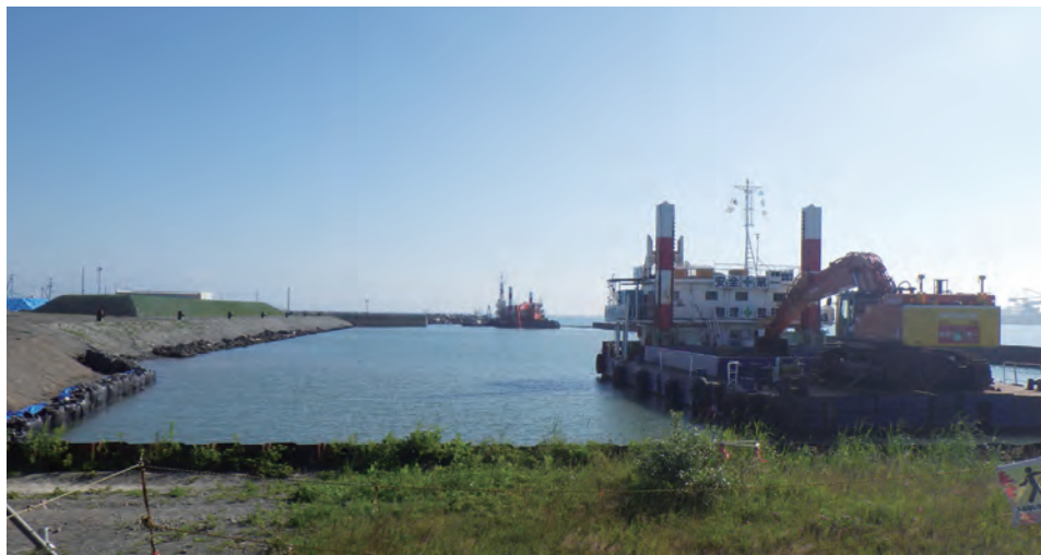
起重機船による港湾施設の工事状況 ▶北海道開発局
