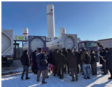
宇宙産業人材の裾野拡大に向けたバスツアーでロケット燃料に使用される液化バイオメタン製造プラントを視察
