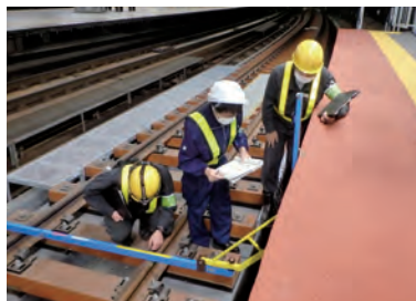
新たに完成したプラットフォームが申請通りの寸法となっているか検査を行う様子
