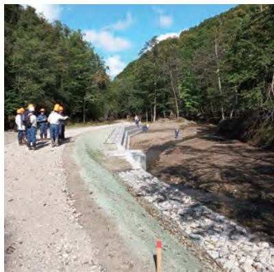
林道改良工事箇所の現地確認 ▶ 北海道森林管理局
