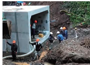
災害箇所の林道工事の様子 ▶ 北海道森林管理局
