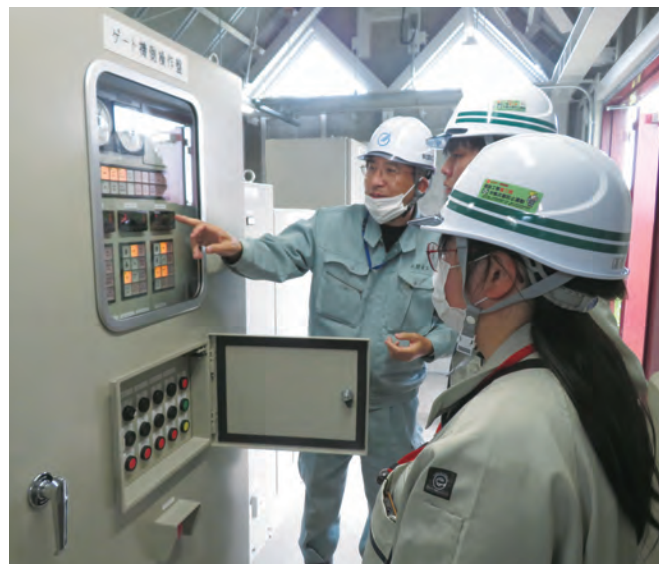
河川管理施設の操作盤確認 ▶ 北海道開発局
