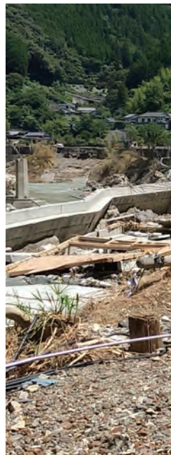
令和2年に九州で発生した 洪水災害箇所での被害状況把握 ▶ 北海道開発局
