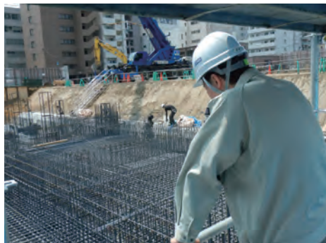
建築物の骨組みを現地で確認 ▶ 北海道開発局
