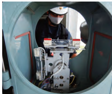
灯台点灯装置にかかる動作確認の様子 ▶ 第一管区海上保安本部
