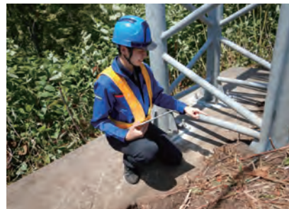
警察通信施設の機能・性能を良好な状態に 維持するため点検している様子 ▶ 北海道警察情報通信部
