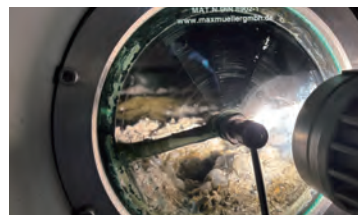
エネルギー生成に活用する家畜ふん尿等が 発酵槽内でメタン発酵する様子 ▶ 北海道農政事務所
