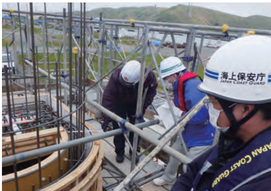
灯台建設にかかる施工状況確認の様子 ▶ 第一管区海上保安本部
