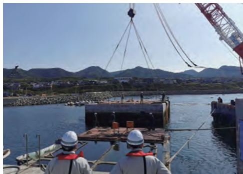
防波堤工事の施工確認（ケーソン据付）▶北海道開発局
