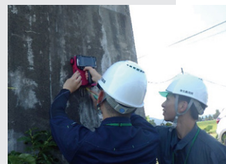
農業用水利施設の調査（機能診断）
