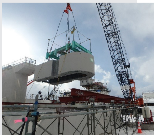
農業用水利施設の工事
