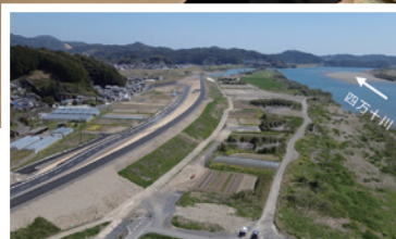
流域治水の加速化・深化(氾濫をできるだけ防ぐ・減らすための堤防拡幅)
