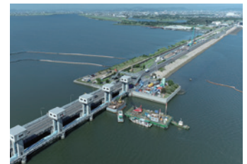
締切堤防の耐震化対策工事 （児島湾沿岸地区）
