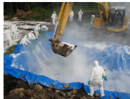
▲埋却作業の様子 (写真提供：宮崎県)
