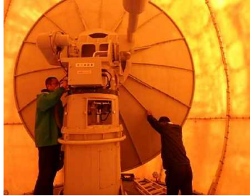
▲ 石垣島レーダー点検作業の様子
