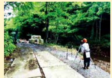
緑に囲まれながらの現場検査
