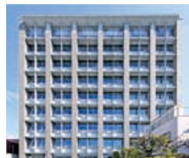
総合庁舎（甲府法務総合庁舎）
