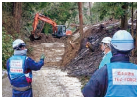
建設業者と連携した 道路の緊急復旧（輪島市）
