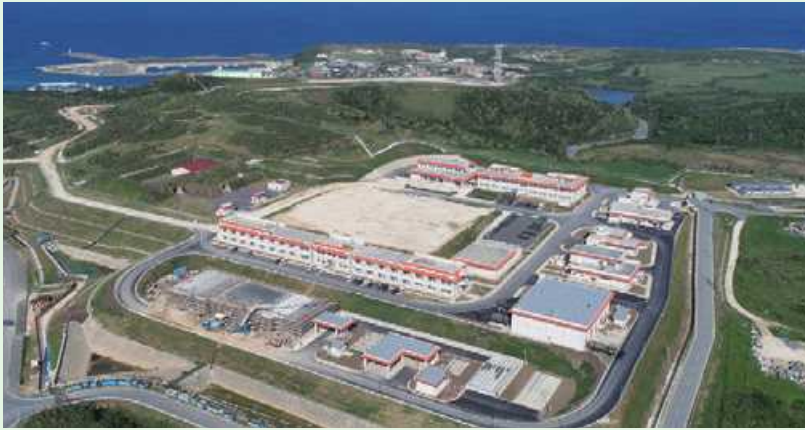
日本最西端の島に建設した与那国駐屯地
