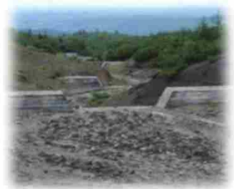
山地災害防止タイプ:十勝岳治山施設
